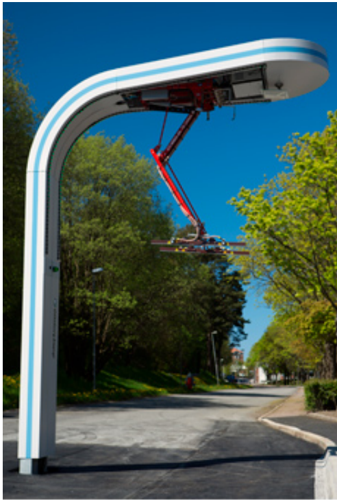
Den bågformade laddarmen faller ner strömöverföringen över bussen och laddar den full på sex minuter.
